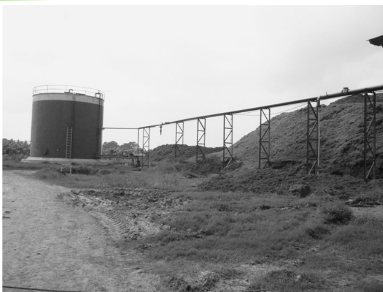
Figura No. 8: Almacén de aceite crudo
