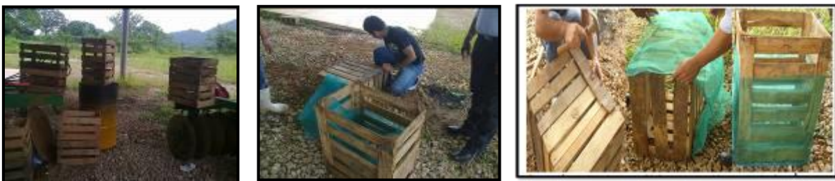
Figura 2. Construcción de contenedores.
